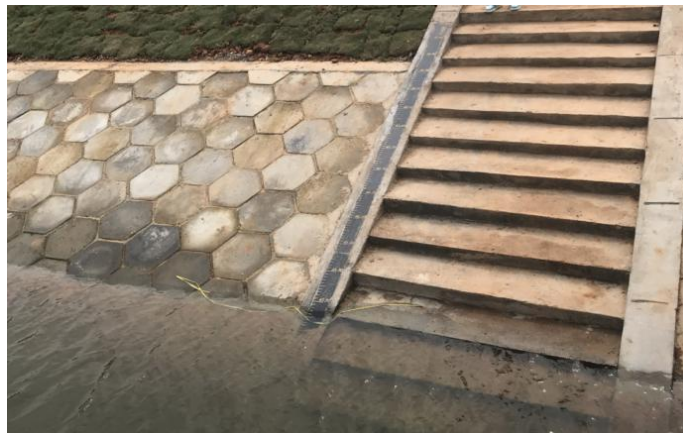
图 2.2-3 斜坡式水位尺
