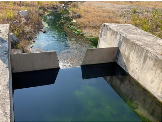
图 2.4-4 矩形量水堰样式图
